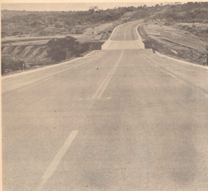
A RABELLO S.A., com as outras firmas que participaram da construção da BR-251, trabalhou intensamente para entregar a obra dentro do prazo fixado.
