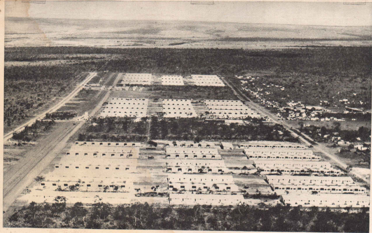
FUNDAÇÃO DA CASA POPULAR - Vista aérea das 500 casas construídas pela F. C. P. e inauguradas em 30-6-1958, de acordo com o Plano Piloto. Projeto de Oscar Niemeyer. Outras 500 moradias (2. a etapa) vão ser construídas pela F.C.P., na administração do sr. Marcial do Lago, seu superintendente, na execução do "Programa Habitacional Presidente Kubitschek".
