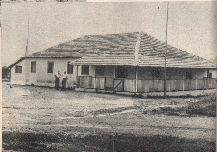
Residência do Presidente - Localizada na antiga "Fazenda da Gama", a cerca de 30 quilômetros do sítio definitivo de Brasília. Aqui se hospeda o Presidente da República nas suas visitas às obras da futura Capital. Prédio simples, mais parecendo uma casa de campo.
