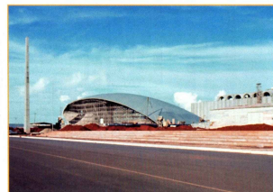
"Concha Acústica" e obelisco em fase de construção
