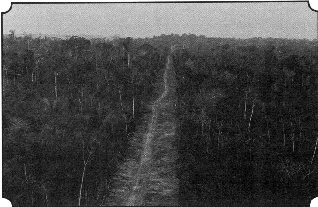
Rodovia Belém-Brasília. Açailândia-MA Autor: Mário Fontenelle Data: 9.dez.1958 Fonte: Arquivo Público do Distrito Federal - Fundo: NOVACAP
