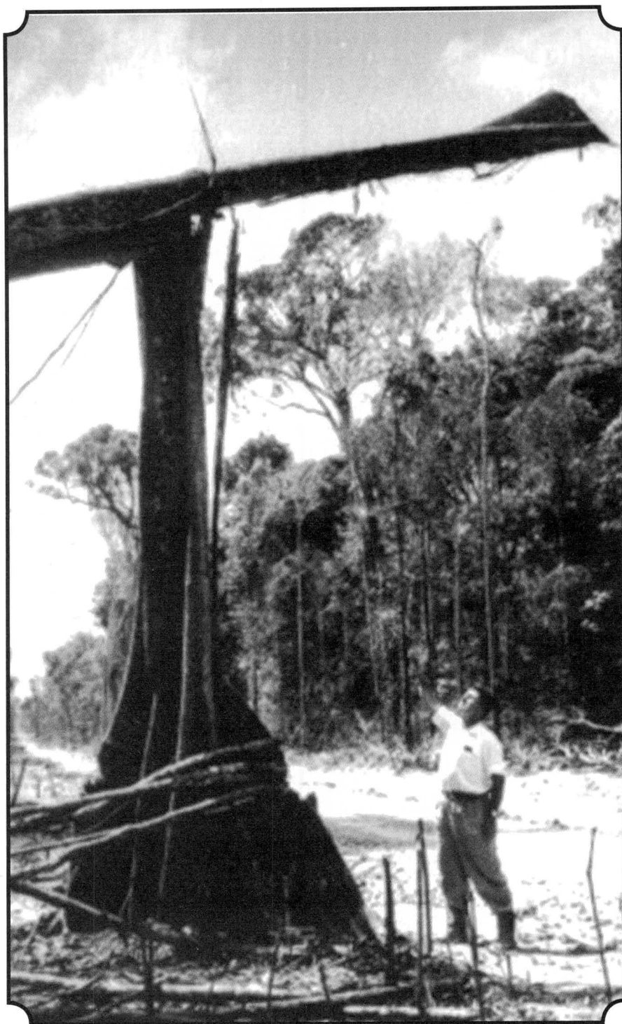
Exposição: "Bernardo Sayão: O Bandeirante Moderno,1991"- Bernardo Sayão na construção da Belém-Brasília Autor: não identificado Data: não identificada Fonte: Arquivo Público do Distrito Federal - Fundo: ArPDF
