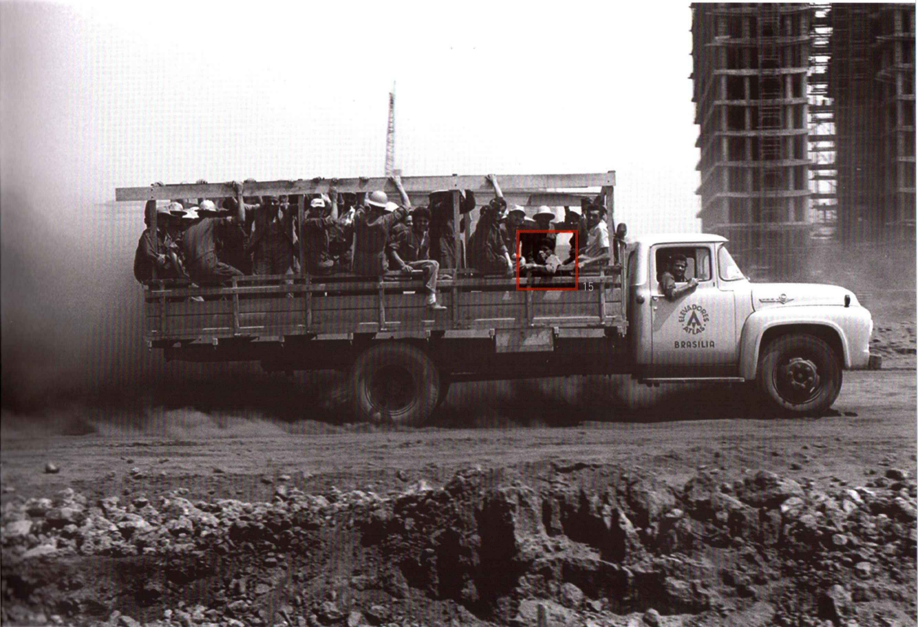
Operários sendo transportados para o canteiro de obras próximo ao Congresso Nacional – 1959
